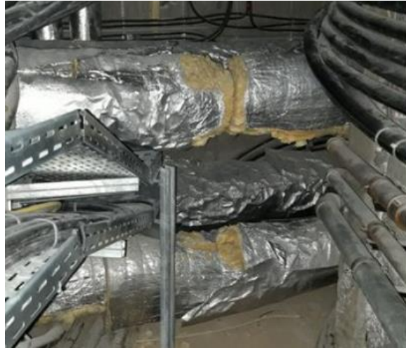
Heizwasserleitungen im Keller von Gebäude C16, vor und nach der Sanierung.
